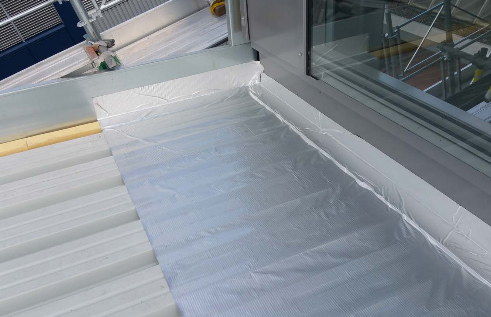
Eine vollflächig selbstklebende Aluminium-Dampfsperrbahn aus Alutrix 600 wurde verlegt.
