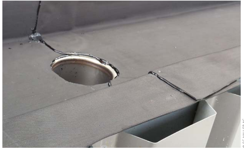
Stutzenausbildung in der ausgekleideten Schedrinne.
