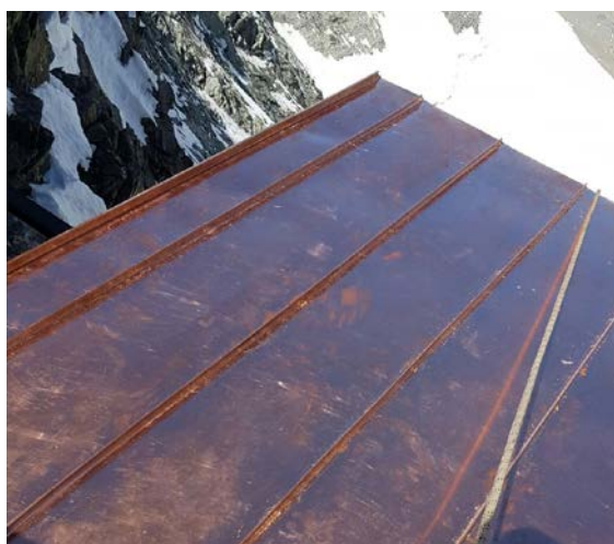
Die Doppelfalzbahnen wurden in der Werkstatt der Richard Gruber AG in Zermatt vorfabriziert und dann mit Helikopter zur Hütte geflogen.
