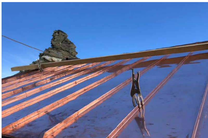
Die ganze Solvayhütte erhielt ein neues Kupferdach.
